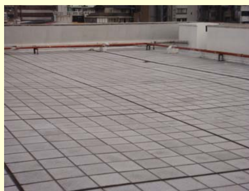
活動中心屋頂防水隔熱工程
